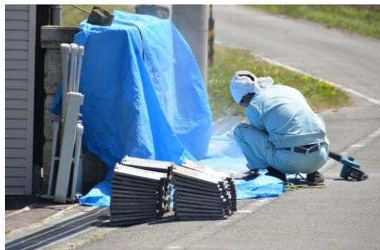
取付ける金具の厚み分を、瓦の裏側を削る。
