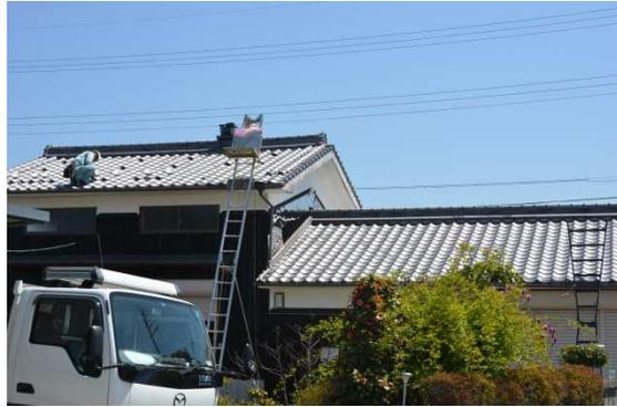
金具設置個所の瓦と左右の瓦、計3枚単位で、瓦を外し土を除き、瓦3枚の大きさの板を置き、屋根下の垂木に固定していく。
