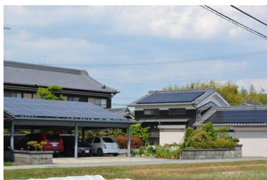
ガレージ上は、N発電所：2年前設置のサンヨー（現パナソニック）。230W36枚の8.28Kw
