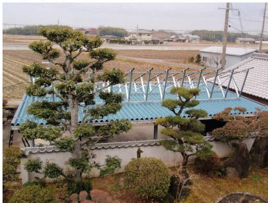
ガレージ4台の上に架台の設置
