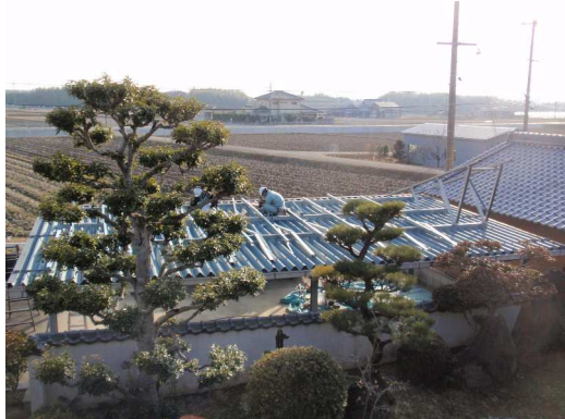
ガレージ4台の上に架台の設置
